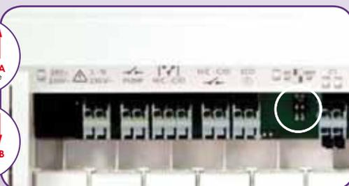
La sélection du générateur de chaleur se fait à partir de l'interface de câblage de la centrale, par simple commutateur.
