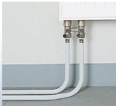
Le raccordement au radiateur peut être effectué, sans aucun accessoire, l'esthétique du tube étant compatible avec la réalisation d'une installation élégante.
