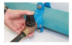
• Engager le tuyau polyéthylène dans l'alésage du robinet équipé du raccord jusqu'en butée
